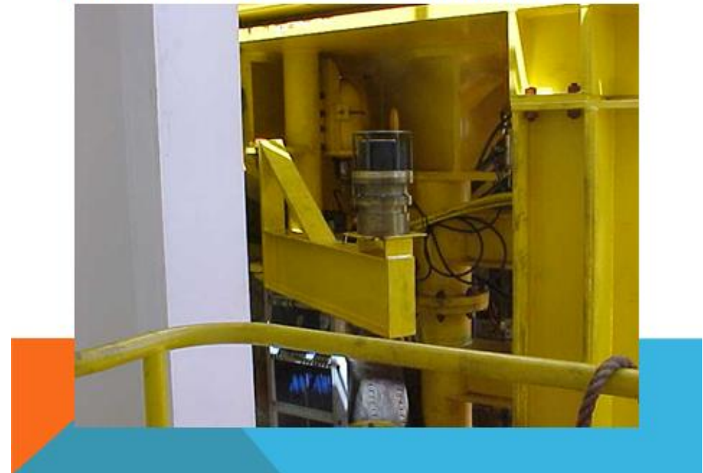
“TRANSCIEVER” DO SISTEMA ACÚSTICO NO BOP
