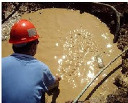
**Figura 10** - Fluido de Completação
